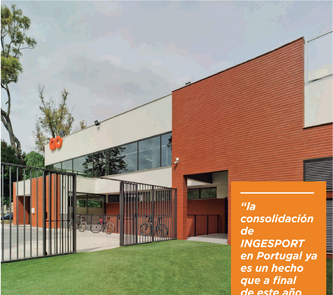
Acceso principal a la instalación
